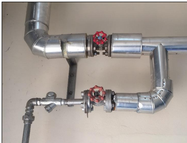
ภาพที่ 63 แสดงการตรวจสอบวาล์วจ่ายไอน้ำของสาขาวิชาเทคโนโลยีอาหาร และสาขาวิชาเทคโนโลยีชีวภาพ
