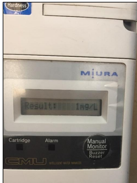
ภาพที่ 32 แสดงการอ่านค่าของแข็งละลายน้ำ (Total hardness) จากหน้าจอเครื่องตรวจสอบคุณภาพน้ำ (Colormetry)
