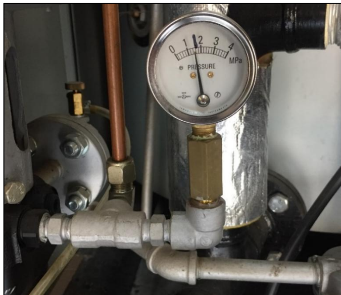
ภาพที่ 61 แสดงการทำงานของเกจวัดแรงดันน้ำมัน (Oil gauge)
