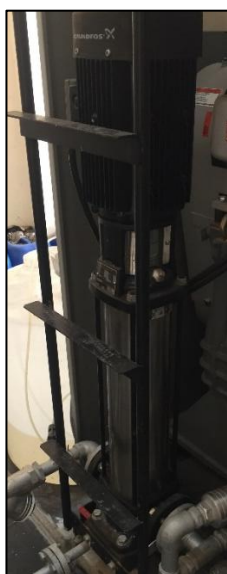
ภาพที่ 50 แสดงการตรวจสอบ Water pump
