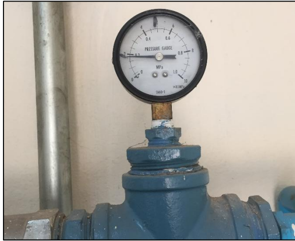
ภาพที่ 23 แสดงการตรวจสอบแรงดันน้ำประปา
