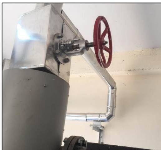
ภาพที่ 62 แสดงตำแหน่งจ่ายไอน้ำหลักของเครื่อง (Steam outlet)
