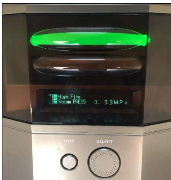
ภาพที่ 58 แสดงไฟแสดงสถานะสีเขียวเริ่มการทำงาน และเครื่องทำงานปกติ
