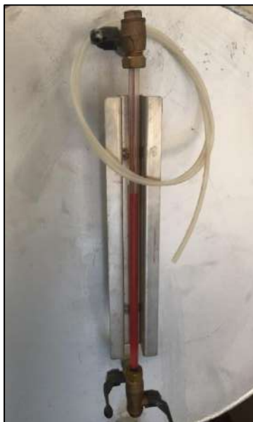
ภาพที่ 25 แสดงการตรวจสอบระดับน้ำมันในถังพัก (Oil tank)
