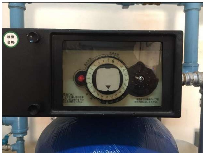
ภาพที่ 39 แสดงการเปิดคำสั่ง Regenerate resin ของเครื่องทำน้ำอ่อน (Softener)
