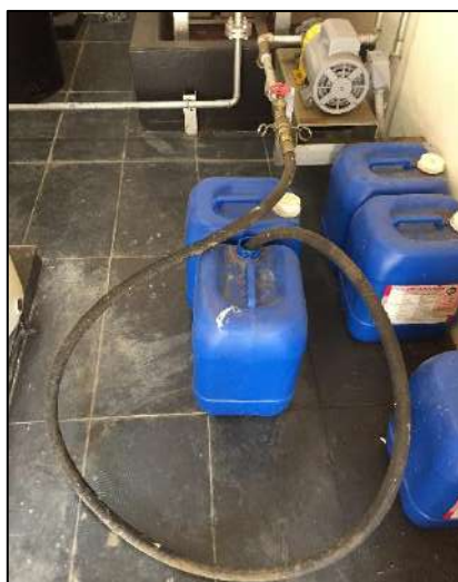
ภาพที่ 26 แสดงการเติมน้ำมันเชื้อเพลิงลงในถังพักโดยใช้ปั๊มเกียร์ (Gear pump)
