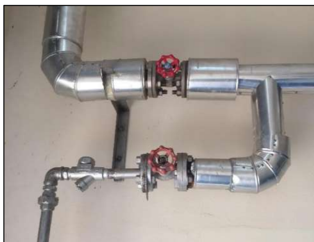
ภาพที่ 44 แสดงการตรวจสอบวาล์วจ่ายไอน้ำของสาขาวิชาเทคโนโลยีอาหาร และสาขาวิชาเทคโนโลยีชีวภาพ
