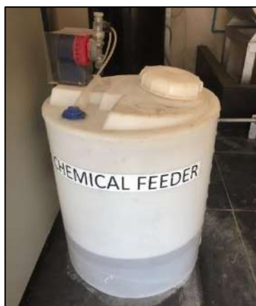
ภาพที่ 27 แสดงถังเก็บสารเคมี (Chemical feeder)
