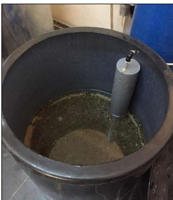
ภาพที่ 38 แสดงการเติมเกลือบริสุทธิ์ลงในถังน้ำเกลือ (Brine tank)
