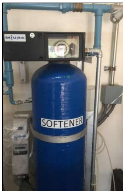
ภาพที่ 30 แสดงเครื่องทำน้ำอ่อน (Softener)
