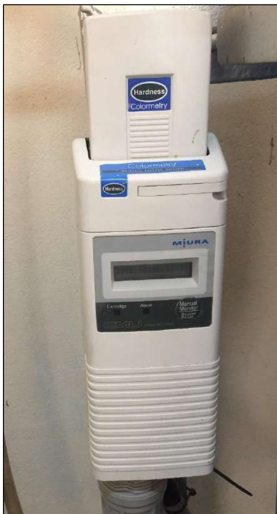
ภาพที่ 22 แสดงการตรวจสอบไฟแสดงผลสถานะพร้อมทำงานของเครื่องตรวจสอบ คุณภาพน้ำ (Colormetry)
