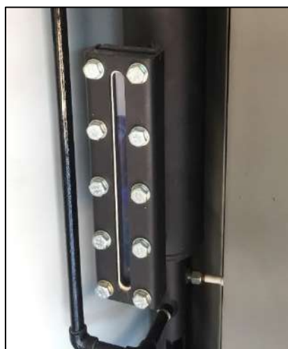
ภาพที่ 46 แสดงการตรวจสอบ Water level gauge
